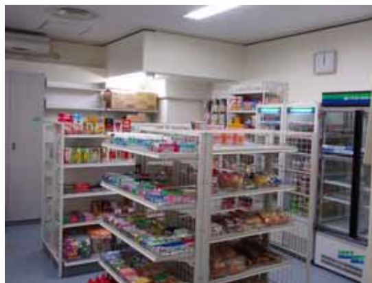
B1階 売店 仕上げ工事完了
