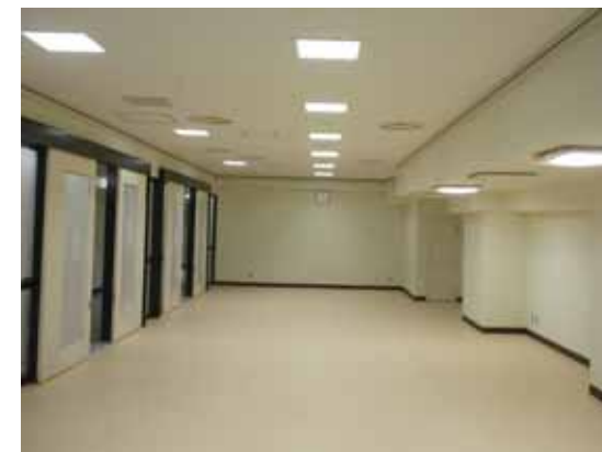
B1階 食堂 仕上げ工事中
