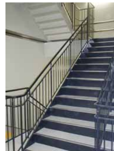
B1階 西階段 免震階段完成
