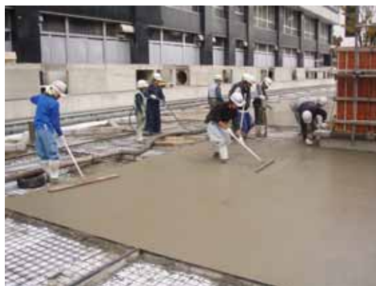
外構 南側 コンクリート打設状況
