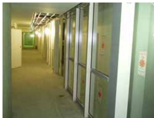
B1階 廊下 食堂間仕切のサッシ・ガラス取付完了
