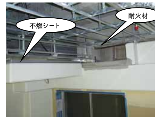
B1階 上部 壁スリットに耐火材と不燃シートを取付けました。
