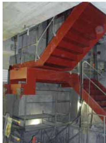
B1階 東階段 鉄骨取付完了
