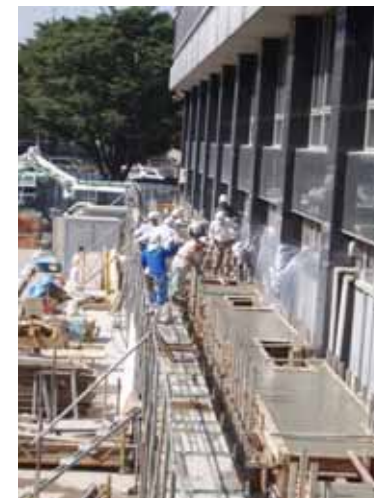
南側バルコニー 設備機器置場コンクリート打設状況
