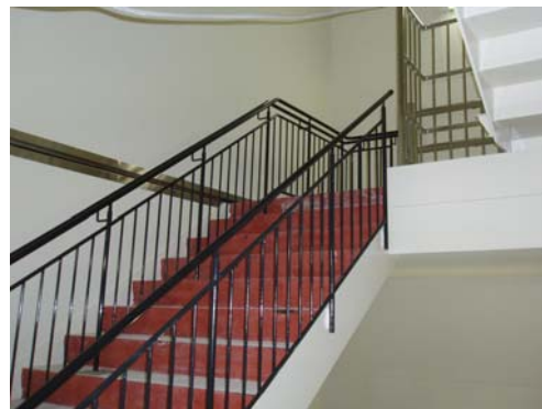
B1階 中央階段 免震階段に改修完了しました。
