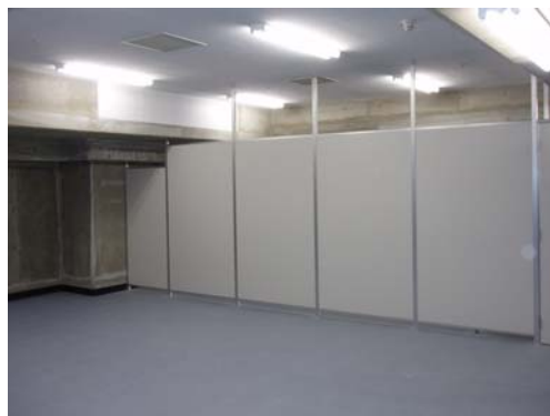
B1階 整備局書庫 内装仕上工事が完了しました。
