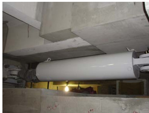
オイルダンパー取付
