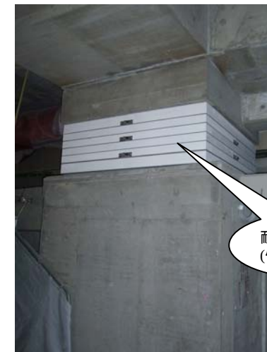
免震装置 耐火材取付
