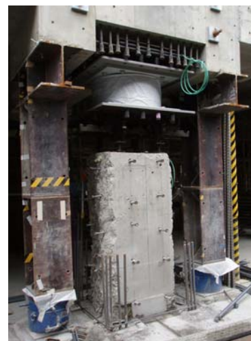
B1階 免震工事
