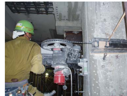
B1階 免震工事 柱切断
