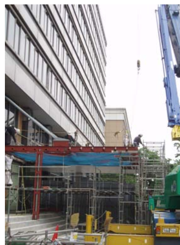
正面玄関 鉄骨底建方中
