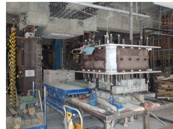
B1階 免震工事
