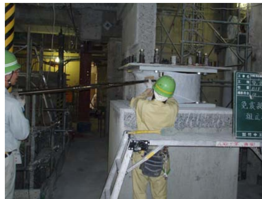
B1階 免震工事
