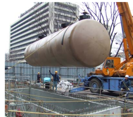
東面 発電機用オイルタンク設置
