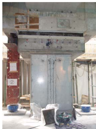
B1階免震工事 仮受支柱ジャッキダウン
