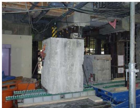
B1階免震工事 旧館エレベーター東側の柱切断
