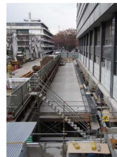
南面外部 1F床コンクリート打設完了
