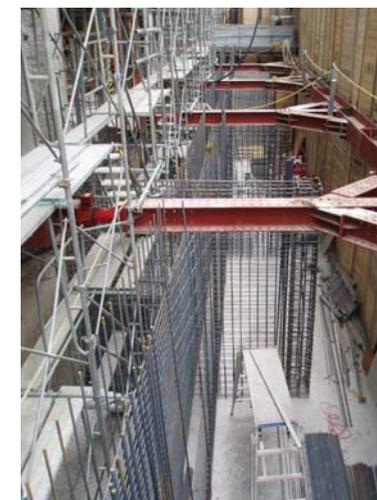
北面外部 B2F壁・柱配筋中
