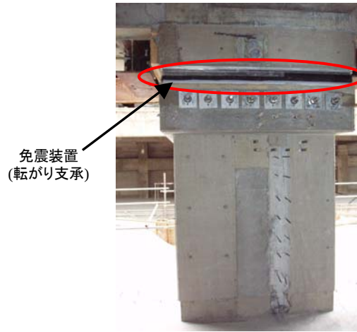
免震装置周囲 鉄筋コンクリート工事 免震装置を取付けた後、その柱を鉄筋コンクリートで補強しました。
