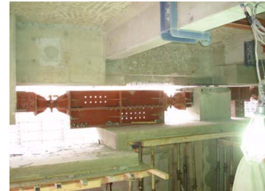
免震装置取付け後 仮固定 免震装置全ての取付けが終わるまで、免震機能を発揮させないよう、仮固定します。
