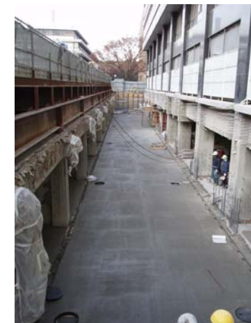
南面車庫 鉄筋コンクリート工事 B1Fの車庫の土間コンクリートを打設完了したところです。
