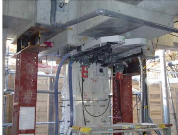
B1F 免震工事 柱切断中
