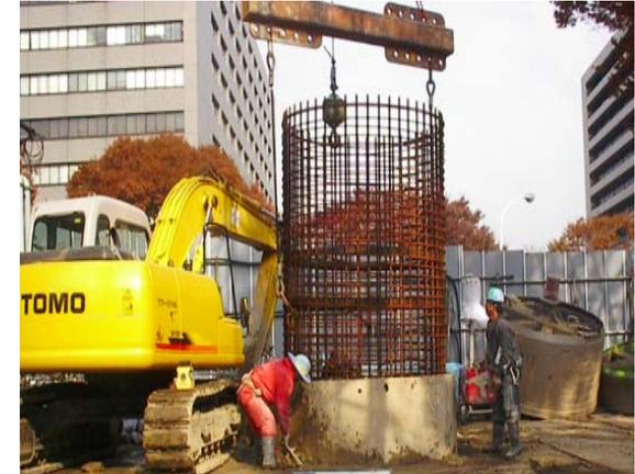
杭工事東面 鉄筋 建込中
