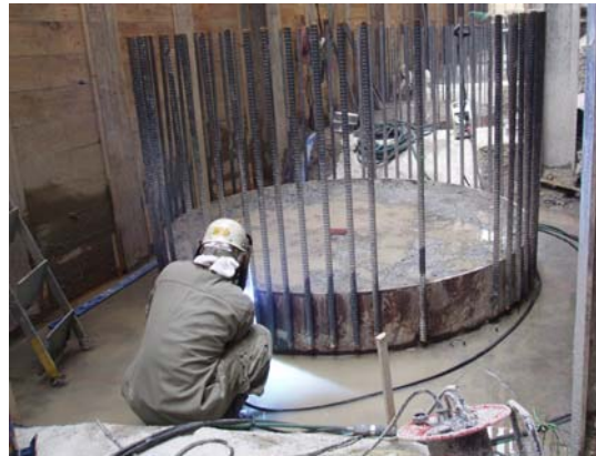
南面基礎躯体工事中。
