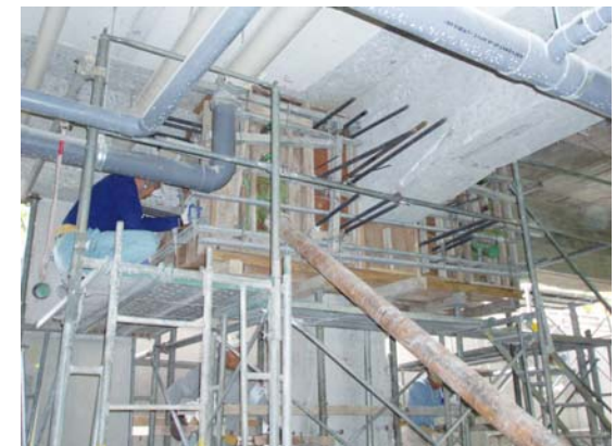
B1F躯体工事施工中。
