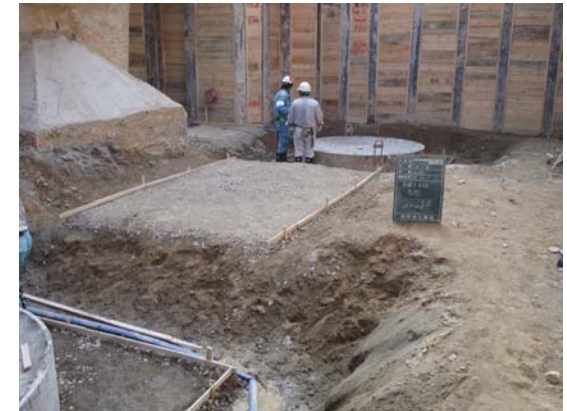
西面基礎躯体工事中。
