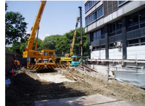
西面山留杭工事中。
