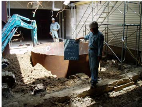
南面杭工事打設中。
