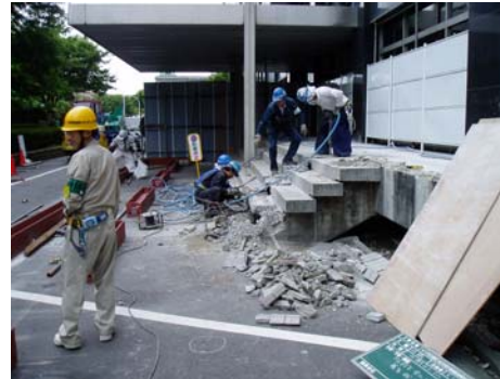
北側正面入口階段撤去工事中。
