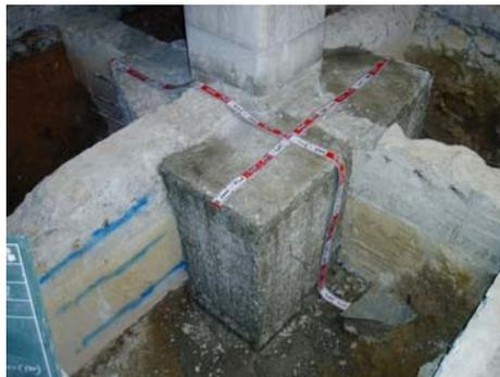
B1F車庫内 基礎の補強コンクリート打設が完了しました。
