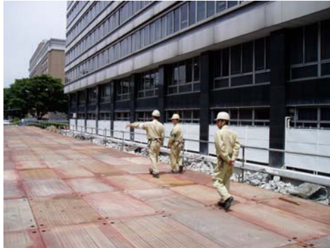
南側仮設工事用構台敷設工事が完了しました
