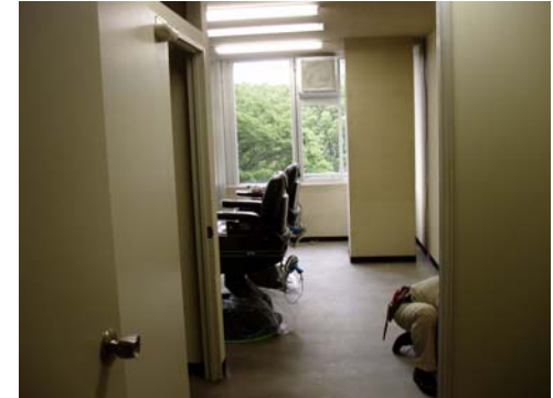
3F仮理髪店舗工事が完了しました
