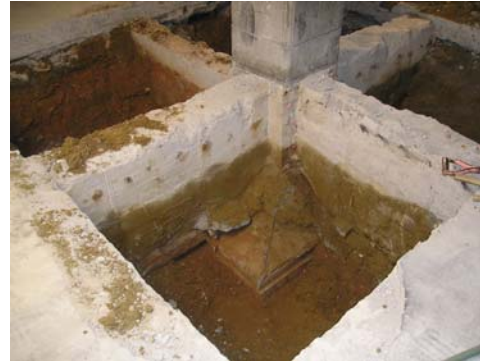
B1F車庫内 基礎の補強工を行っています
