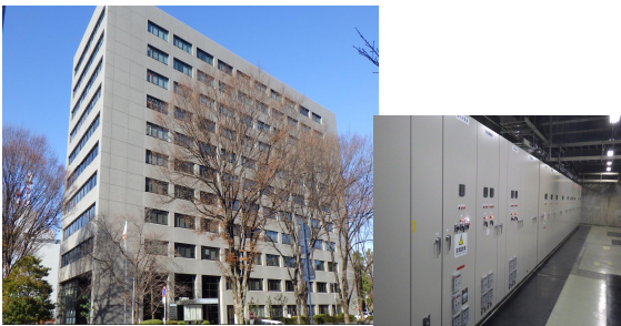
＜令和3年度 名古屋第1地方合同庁舎電気設備改修工事＞
