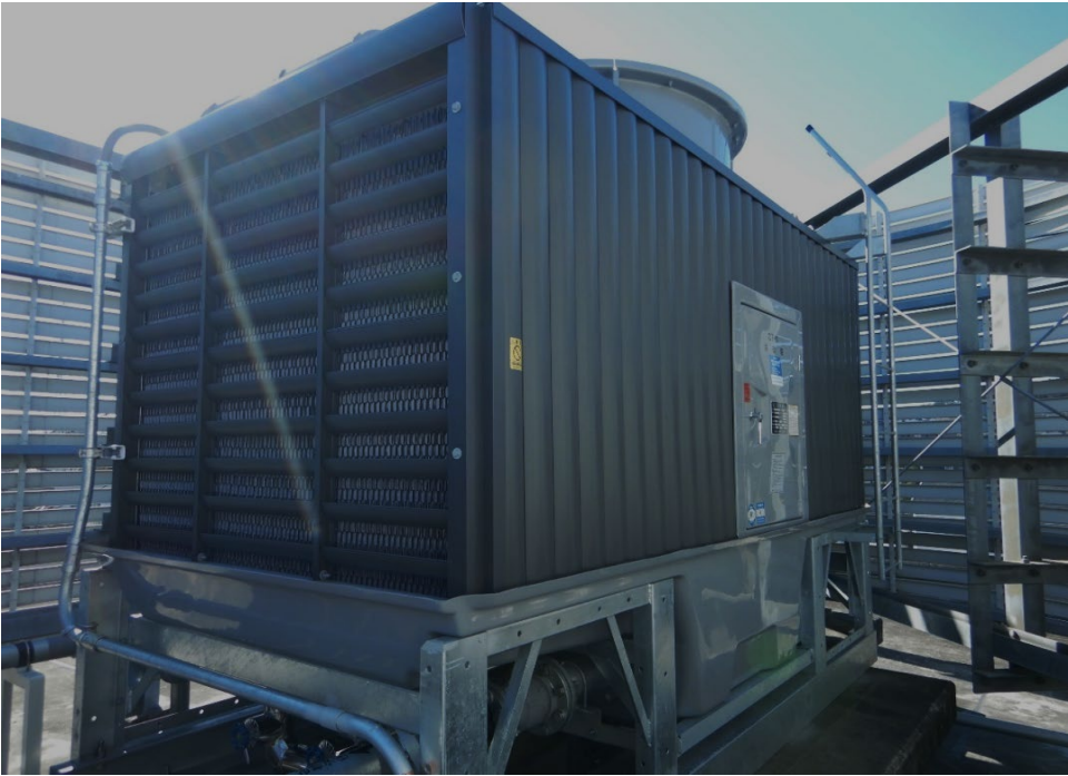
令和4年度 富士宮公共職業安定所空調設備改修工事
