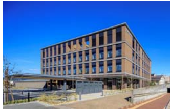
高山地方合同庁舎
