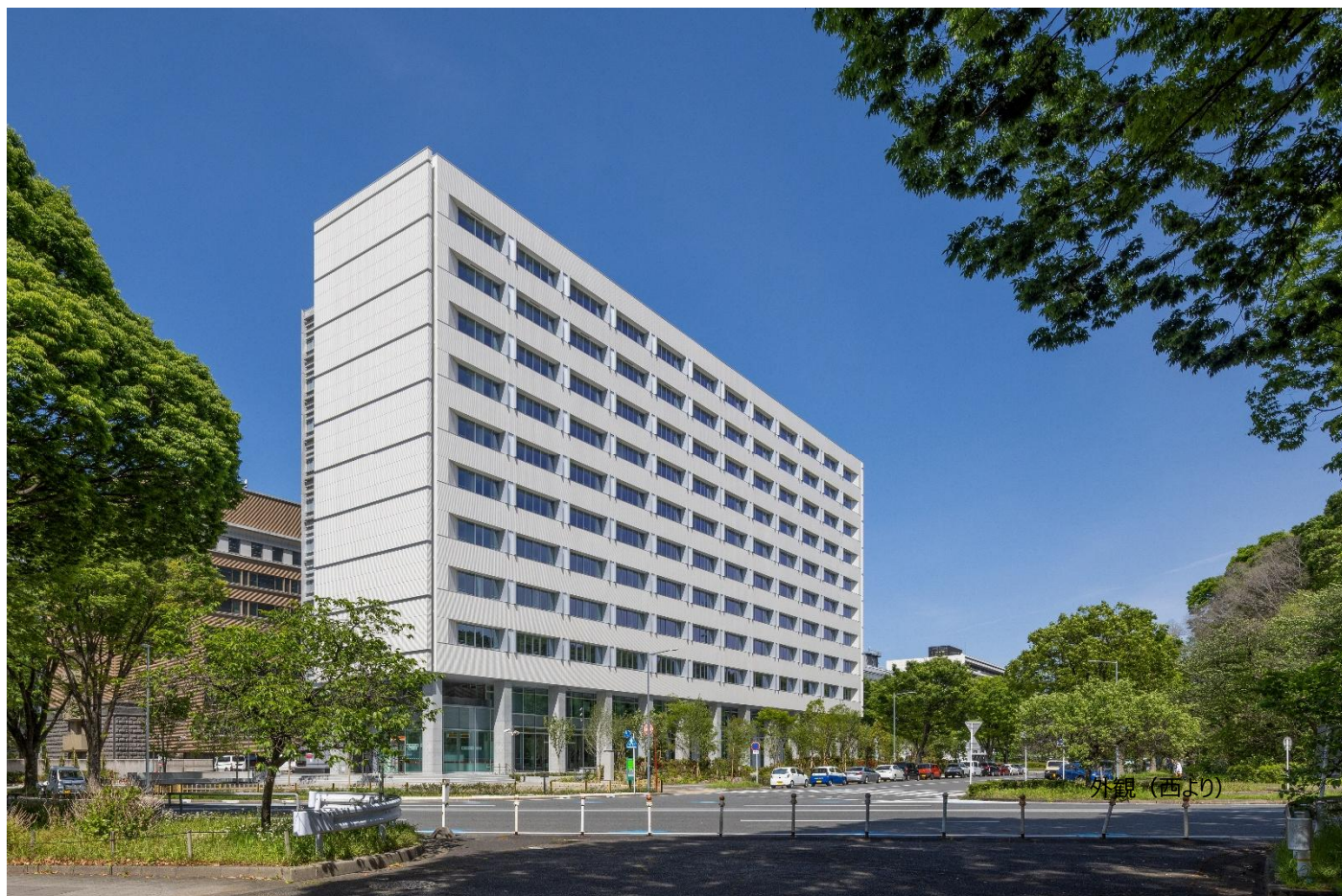
庁舎外観（南西側）
