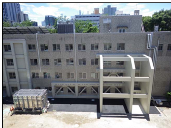
建物(南館北面)外観
