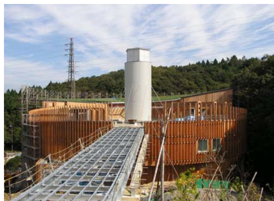
瀬戸日本館：鉄骨造4階建、延べ3,000㎡
