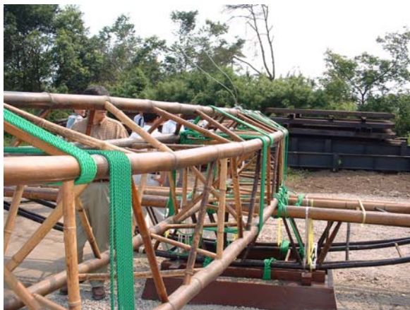
竹トラスの試験組み立て状況
