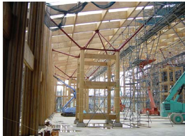
組み柱の施工状況
