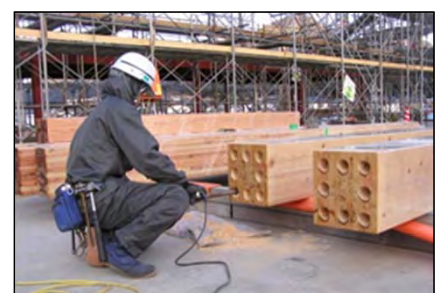
設楽町役場 基礎アンカー筋に穴開けた柱材を建て込む
