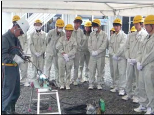
これぞ職人の技：鉄筋ガス圧接
