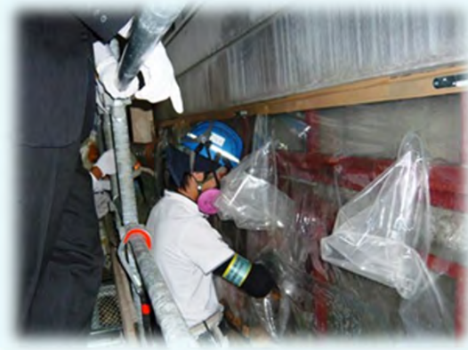
アスベスト部分隔離工法の実演
