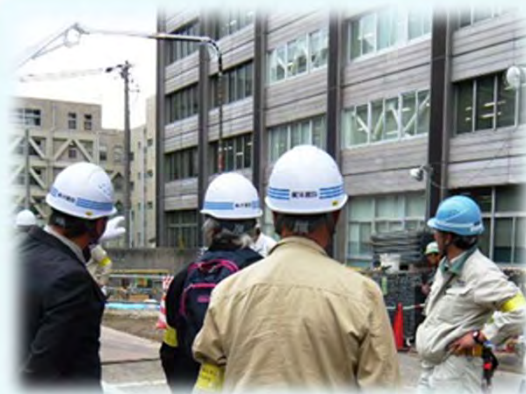
制震ダンパー完成部の説明
