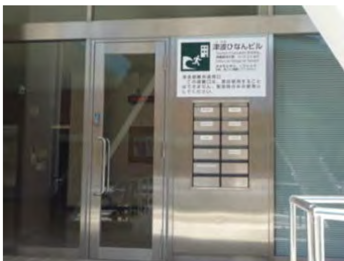
1 階玄関部の非常扉
