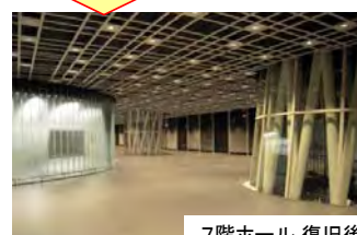
7階ホール 復旧後
