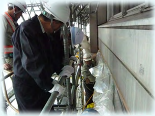
アスベスト部分隔離工法の詳細説明
