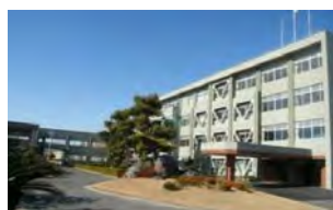
鉄骨ブレースによる耐震補強
