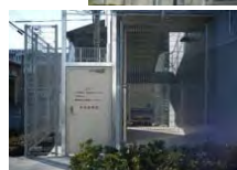
津波避難階段の非常用侵入口
