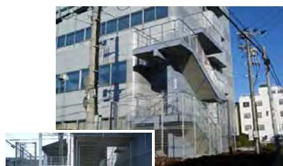
津波避難階段の新設
