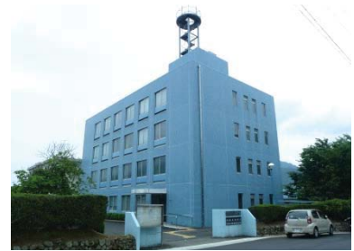
【尾鷲地方合同庁舎】
