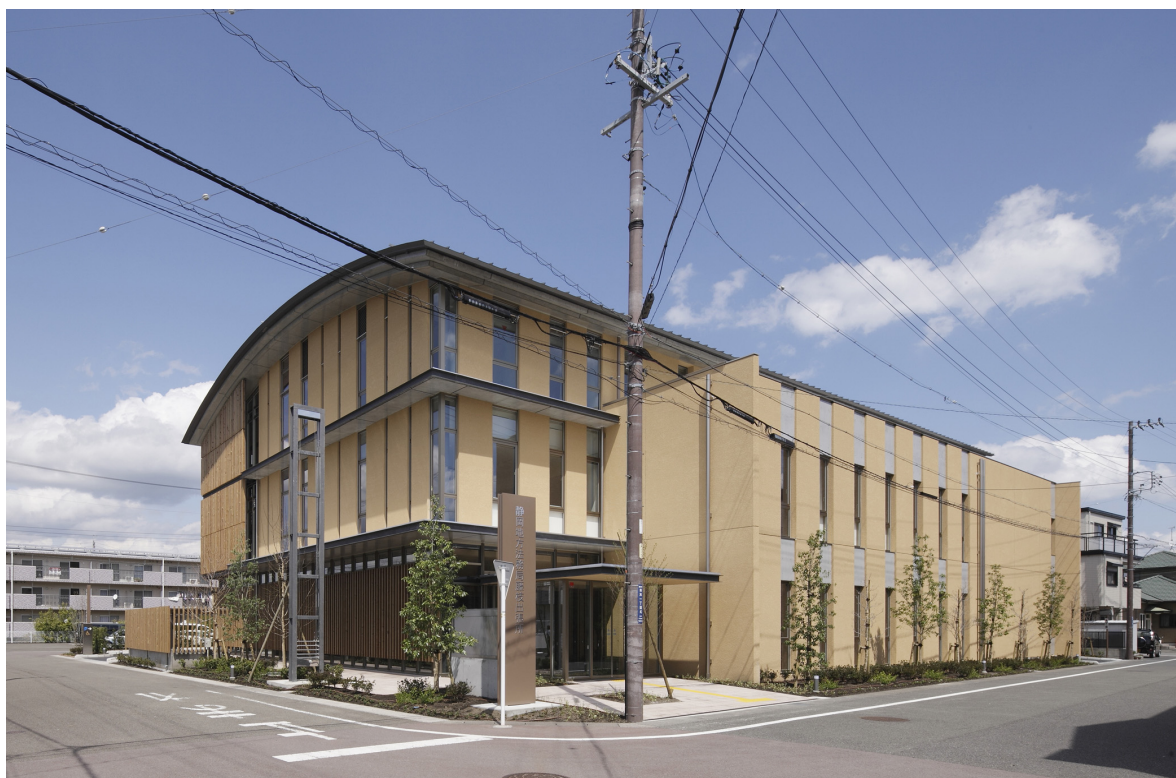
□□□ 静岡地方法務局藤枝出張所(完成写真) □□□□
