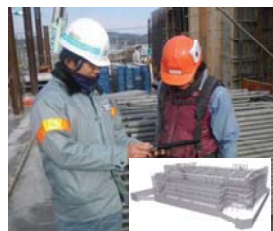
現場での打合せ様子
