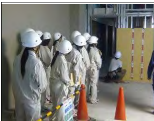
仕上げ材施工の管理と実演
