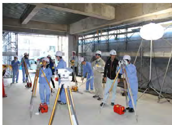
レベル据付・墨出し体験
