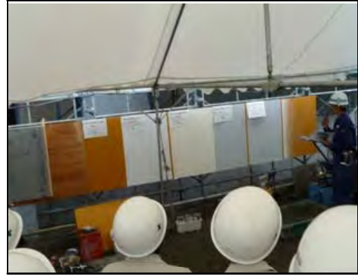
外壁仕上げ工法手順の説明
