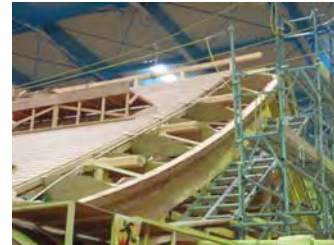
玄関棟の屋根工事
