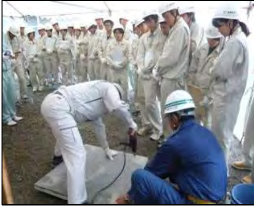
外壁外断熱工法の実演
