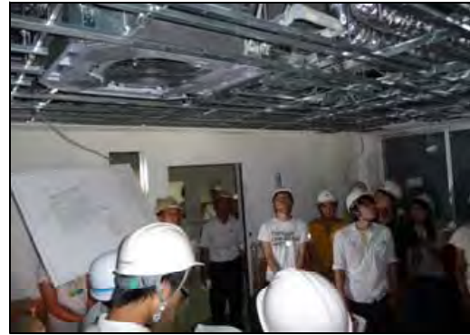
配管配線施工管理方法の詳細説明
