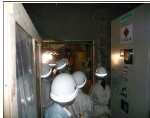
自家発電設備の詳細説明
