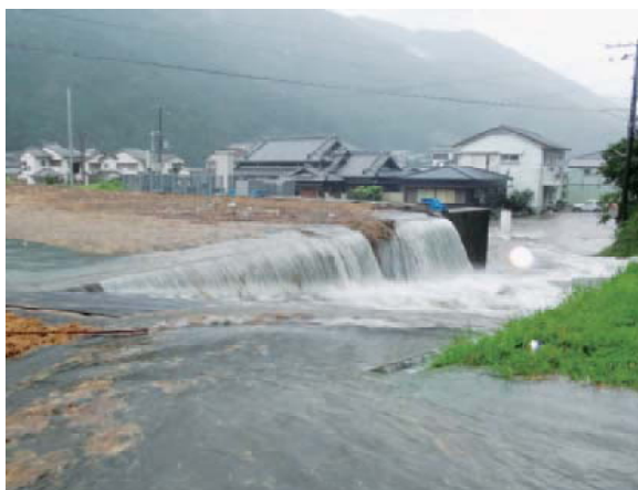
【写真】紀宝町高岡地区の輪中堤防を越えて集落へ浸水する様子／右に見える2階建ての屋根は殆ど浸水した
