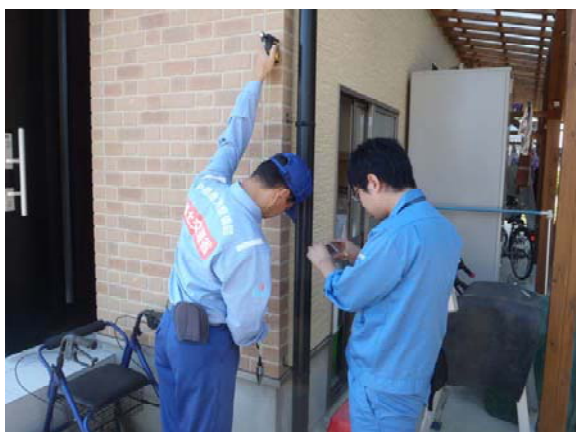
【写真】住家の傾斜度を計測中
