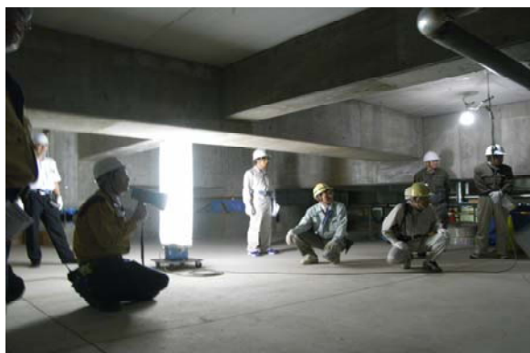
◆地下免震ピットで点検中
