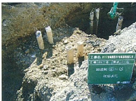
既設杭確認掘り状況
