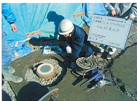
杭頭すべり支承設置状況
