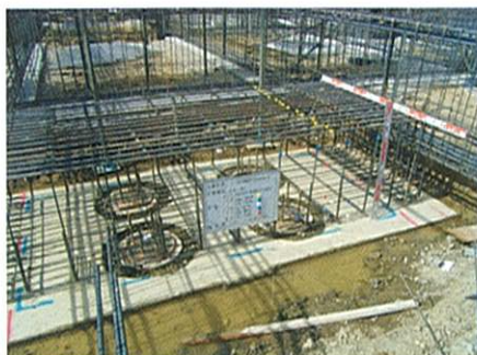
基礎フーチング配筋状況
