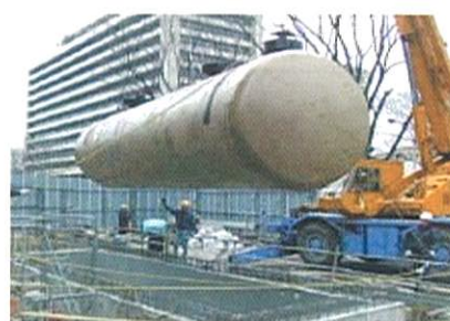
地下タンク施工状況
