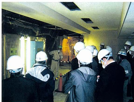
工事検査の臨場（現場立会の写真）
