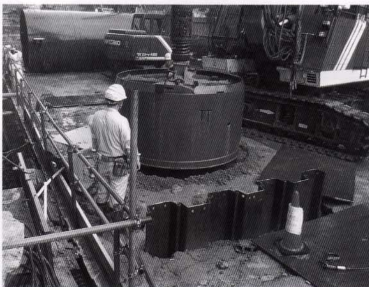
場所打ちコンクリート杭施工状況
