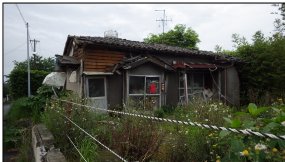
管理放棄された空き家が大きく損傷
