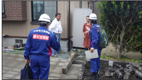
コンクリートブロックの倒壊が目立つ
