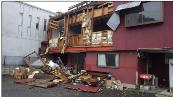
無傷の建物の隣で、大きく破損した建物
