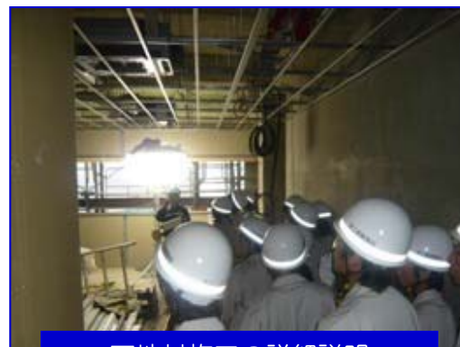
下地材施工の詳細説明
