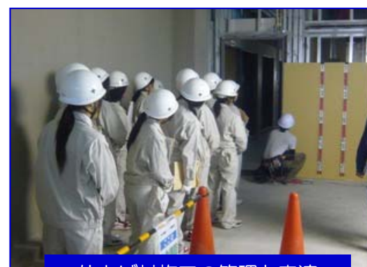
仕上げ材施工の管理と実演
