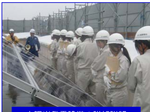
太陽光発電設備の詳細説明
