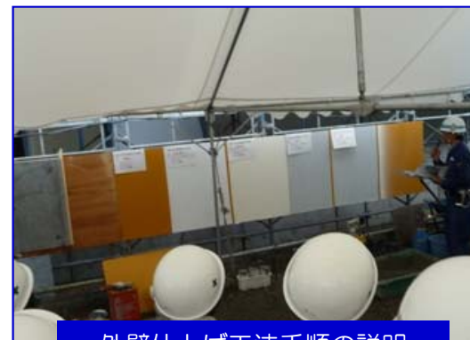
外壁仕上工法手順の説明
