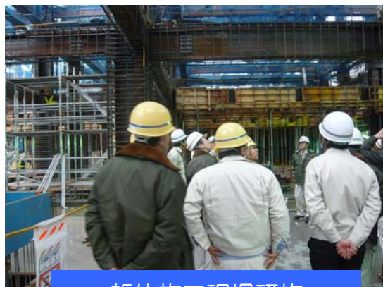
躯体施工現場研修
