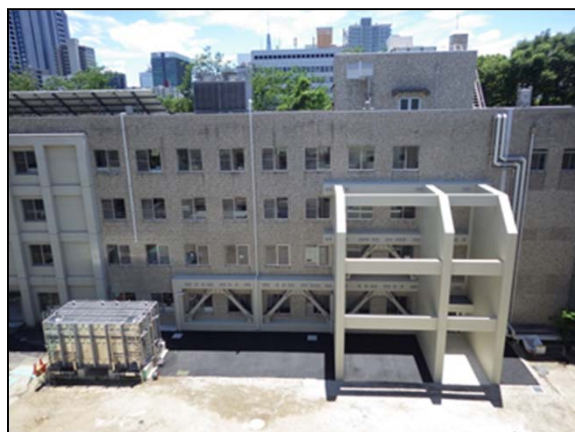
建物(南館北面)外観
