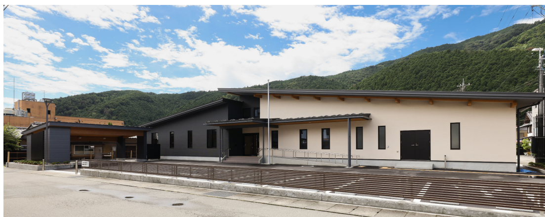
北面(正面)外観
