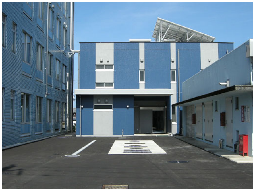
増築棟西面 外観
