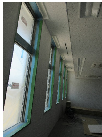
建具の取付け現場
