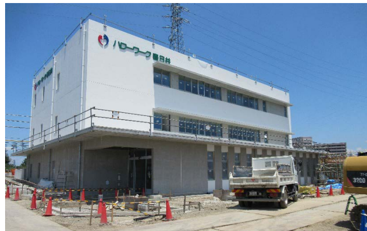
初めて携わった新築工事の現場 「春日井公共職業安定所」
