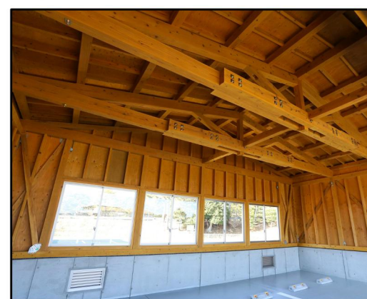
番号標取付作業上屋 内部
