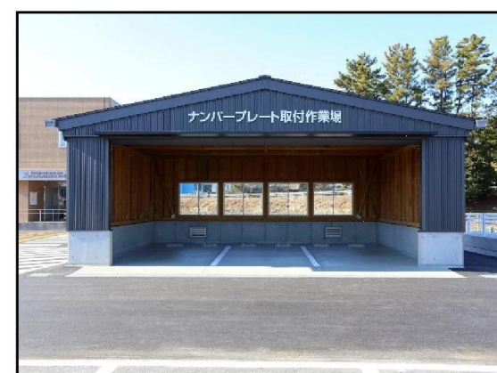
番号標取付作業上屋
