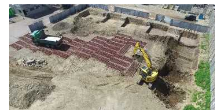
ICT建築土工 本工事での掘削積込
