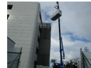
津波対策(電気設備上階移設)
