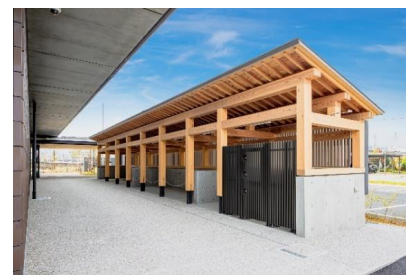
自転車置場の木造化 (高山地方合同庁舎)
