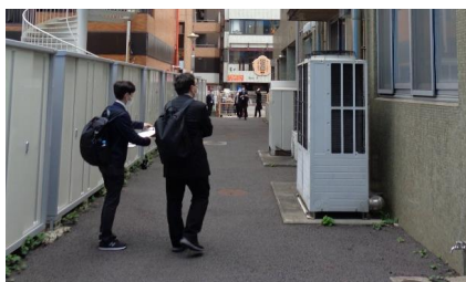
老朽化の状況を調査
