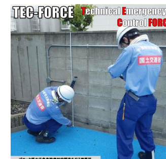
ブロック塀の応急危険度判定調査を行うTEC-FORCE
