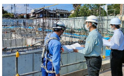
現場での施工品質確認
