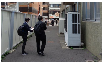
老朽化の状況を調査
