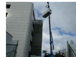
津波対策(電気設備上階移設)
