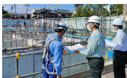
現場での施工品質確認
