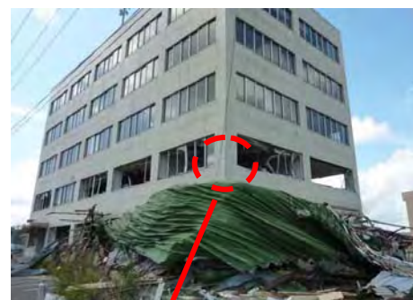
漂流物（隣棟の屋根材）の衝突
