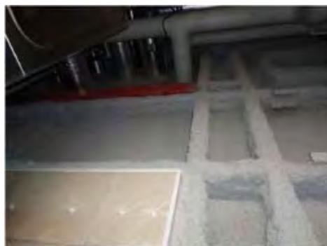
写真4 ポンプ室(X方向)
