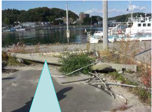
電力引込部分： 電力引込柱が津波により倒壊した例
