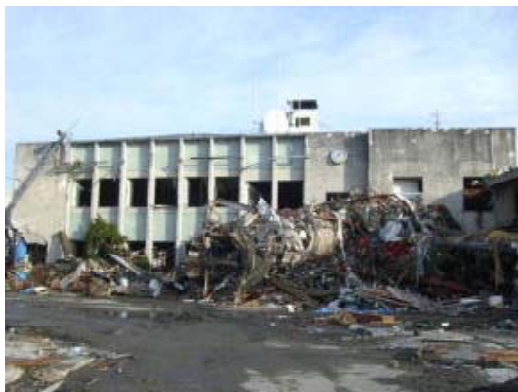
津波により被災した町役場
