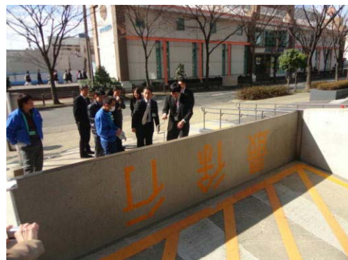
駐車場入口の止水板動作訓練
