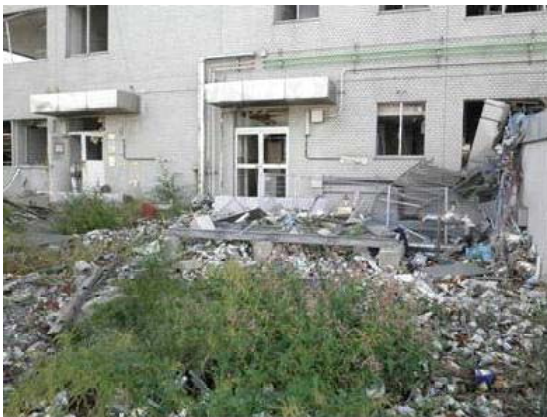
受水槽が流出し基礎のみが残る。
