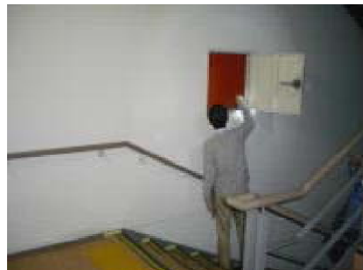
制振壁の目視点検
