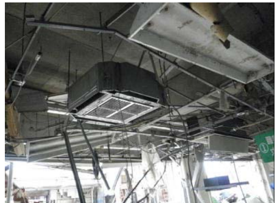
津波により天井の機器が損壊
