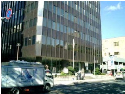
合同庁舎の外観
