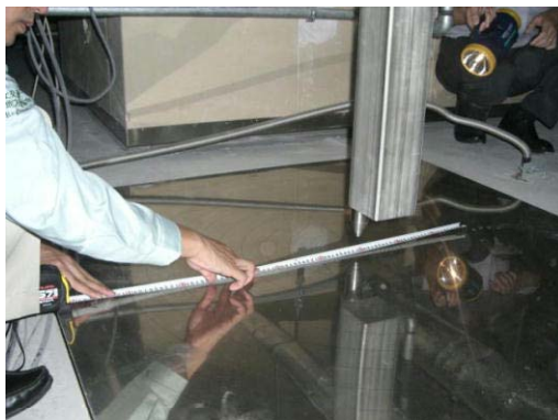
免震のけがき式変位記録装置
