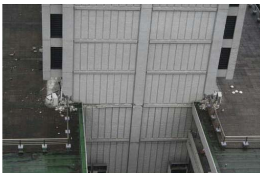
人間・環境系研究棟の妻壁
