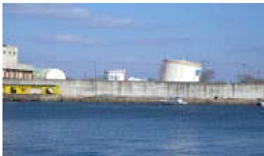
地震により転倒した石油タンク(久慈港)
