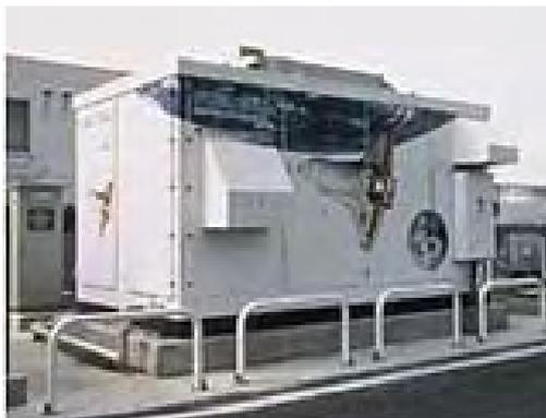
燃料電池システム(リン酸型)
