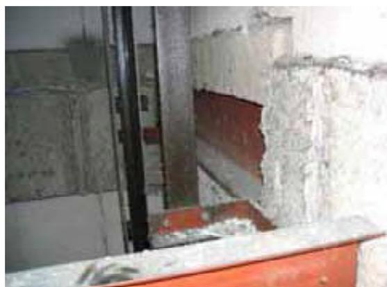
シャフト内壁面の耐火材が剥がれ落下
