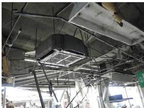
津波により天井の機器が損壊
