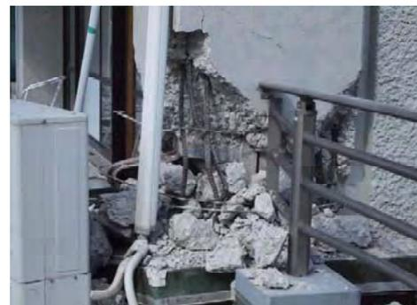
東側妻壁南側の外柱の被害状況
