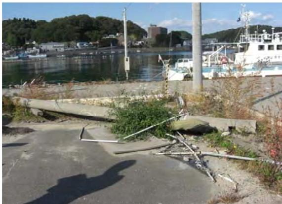
電力引き込み柱が津波により倒壊
