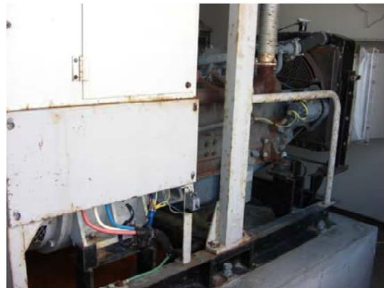
低層階の自家発電設備が浸水し停止
