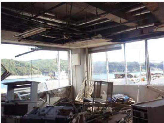
津波により内装が激しく損傷
