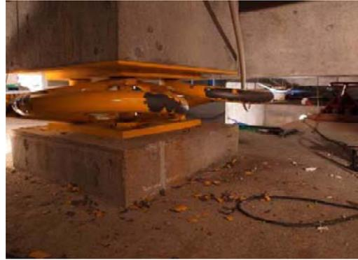
鋼棒ダンパーの塗装の剥がれ
