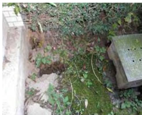
排水管と排水ますの間に断絶
