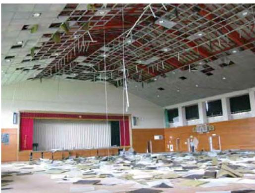
体育館での天井材・下地材の脱落
