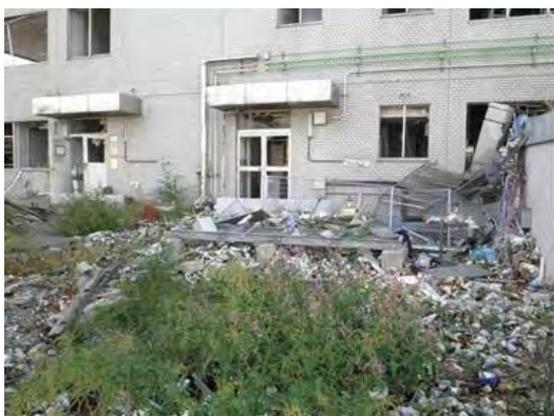
受水槽が流出し基礎のみが残る。
