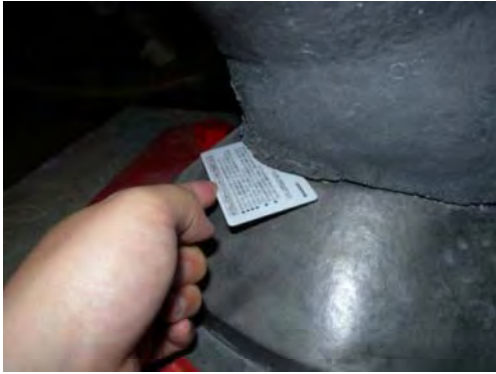
鉛ダンパーのひび割れ状況
