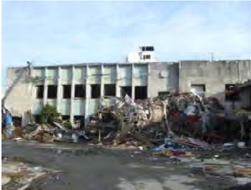
津波により被災した町役場
