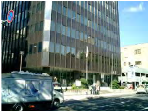
合同庁舎の外観
