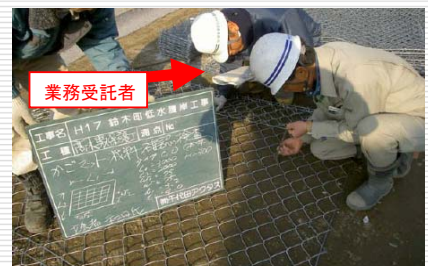
（河川護岸用かごマットの材料確認）
