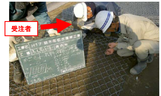
(河川護岸用かごマットの材料確認)
