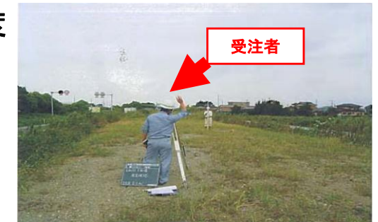
(現場状況の照合を実施)
