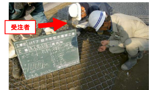
(河川護岸用かごマットの材料確認)
