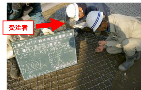
(河川護岸用かごマットの材料確認)
